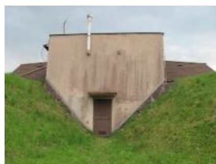
Vodárna U Křížku
