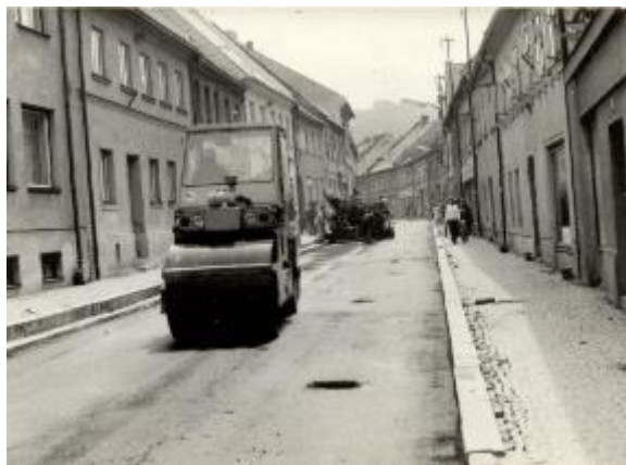
Asfaltování Dlouhé ulice z r. 1978
