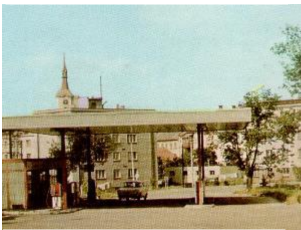
Benzinka z r. 1973 u hlavní silnice
