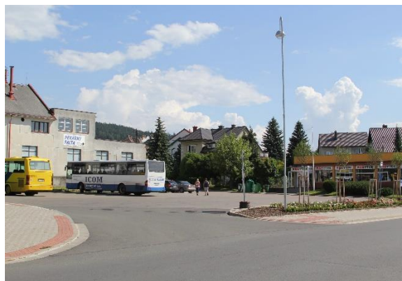
Rekonstruované autobusové nádraží
