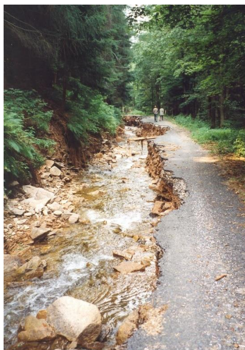
Povodní poškozená lesní cesta Mlýnice v oblasti K. Sněžníku
