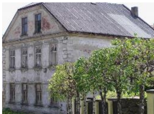
Bytový dům z počátku 20. století
