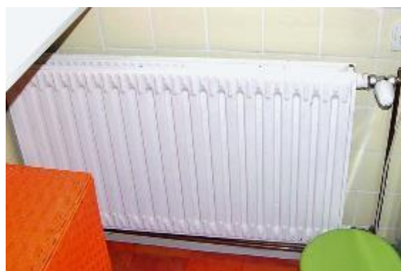
Plynový kotel, radiátor
