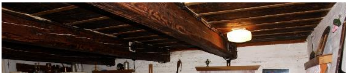
Trámový zákloповý strop
